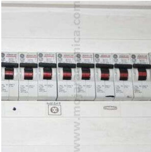
Povećanje struje iznad vrednosti koje mogu da izdrže **provodnici** može biti izazvano kratkim spojem ili priključenjem potrošača prevelike snage. Pri pojavi ovakve struje provodnici se brzo zagrevaju i upravo ova situacija je najčešće uzrok požara u kući. Zadatak automatskog osigurača je da pri porastu struje prekine strujno kolo i na taj način zaštiti kablovi a time i Vašu imovinu.
